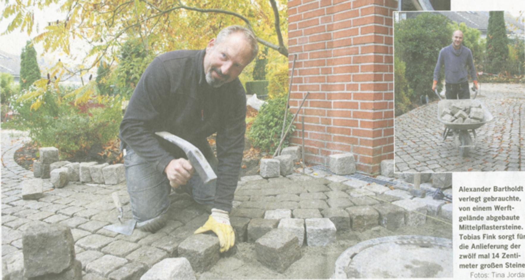
Alexander Bartholdt verlegt gebrauchte, von einem Werftgelände abgebaute Mittelpflastersteine. Tobias Fink sorgt für die Anlieferung der zwölf mal 14 Zentimeter großen Steine
