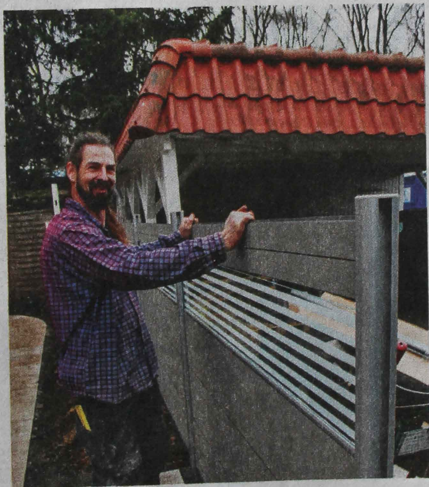
Garten- und Landschaftsbauer Peter de Jong legt letzte Hand an bei einem WPC-Zaun, der aus einem Naturfaser-Kunststoffgemisch besteht und als pflegeleichter Sichtschutz montiert wird
