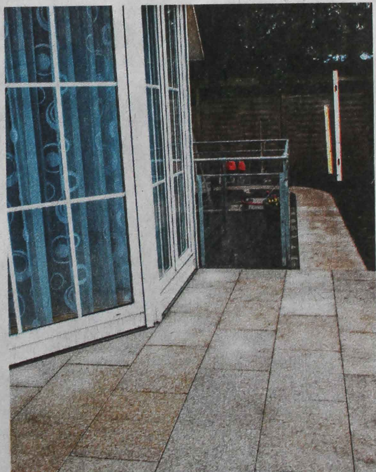
Granitplatten werden auf Naturscheinschotter und Splitt verlegt und sind so unverwundlich sowohl auf der Terrasse als auch auf Gartenwegen
