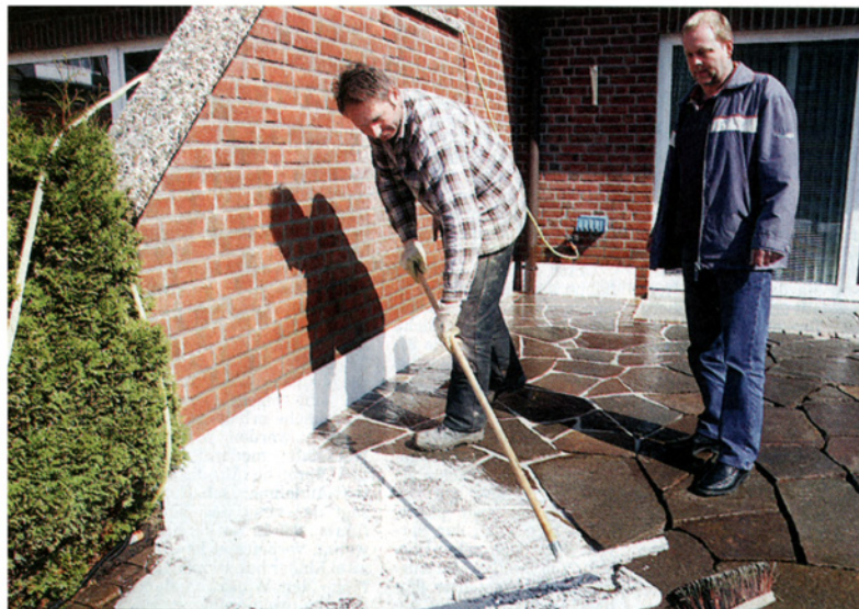
Für die Enderbeiten dieser Terrasse benötigte Landschaftsbaumeister Alexander Barthold (37, links) 15 Elmer Fugenmörtel. Martin Mau (42) baut neben Gartenanlagen auch Eingangspodeste, Zuwegungen und Teichanlagen.
